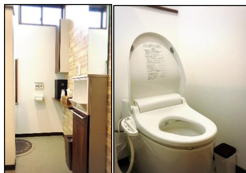
トイレの洋式化改修
